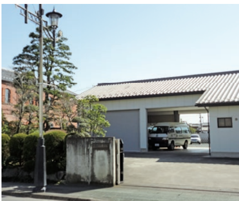
中山道沿いの倉庫 (旧本庄商業銀行煉瓦倉庫となり)
